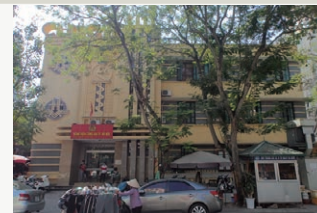
64 Police Hospital 89 Lý Thương Kiệt, Cửa Nam, Hoàn Kiếm 1936, Hospital, Unknown
