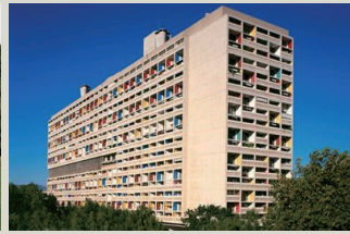
Fig.2 Unité d'Habitation, Marseille, France, 1945
