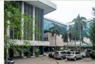
83 Per Tamina Hospital
